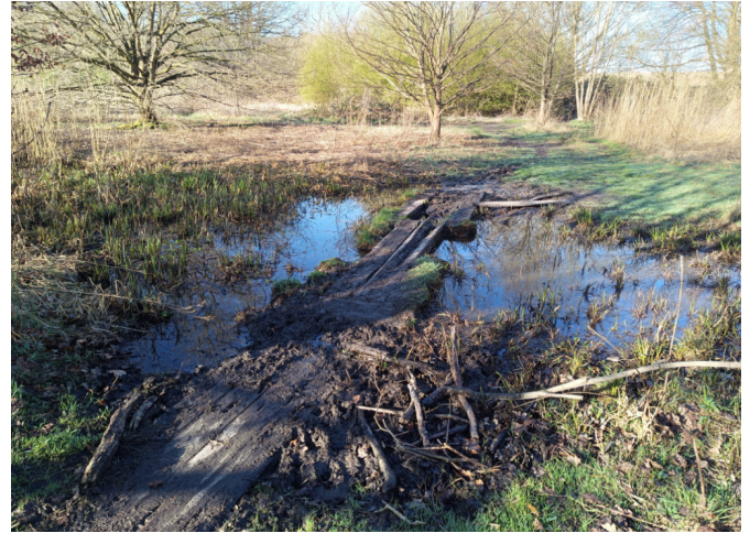
Angestauter Kuhlensiepen an einer provisorischen Gewässerquerung.
