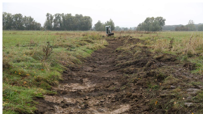
Im Herbst wurde die Zulaufrinne flach gebaggert.
