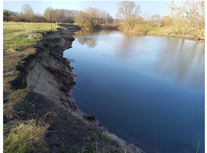
Vom Lippeverband im Spätsommer 2024 neu gestaltete Ufersteilwand im Bereich Langerner Hufeisen.
