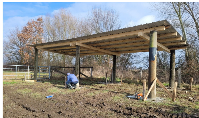
Im Februar 2025 hat der Weidetierhalter ein neuen Weideunterstand mit Fangvorrichtung und Fressgitter aufgebaut.
