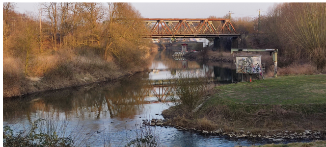
Bauarbeiten zur Fahrradbrücke über die Lippe machten Teile des Rundweges unpassierbar.
