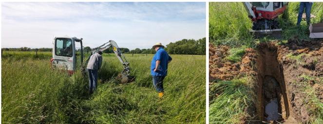
Probeschurf mit dem Minibagger der Biostation zur Erkundung von Sandvorkommen und wasserhaltender Stauschichten am geplanten Standort.
