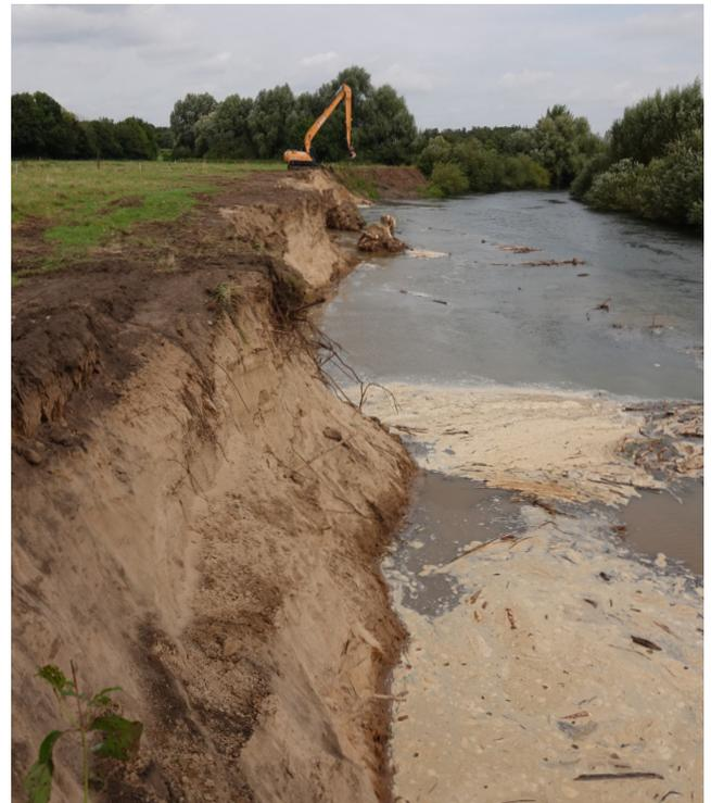
Der Langarmbaggerfahrer arbeitete parallel zur Böschung und berücksichtigte die Beschaffenheit der vorliegende Bodenarten.
