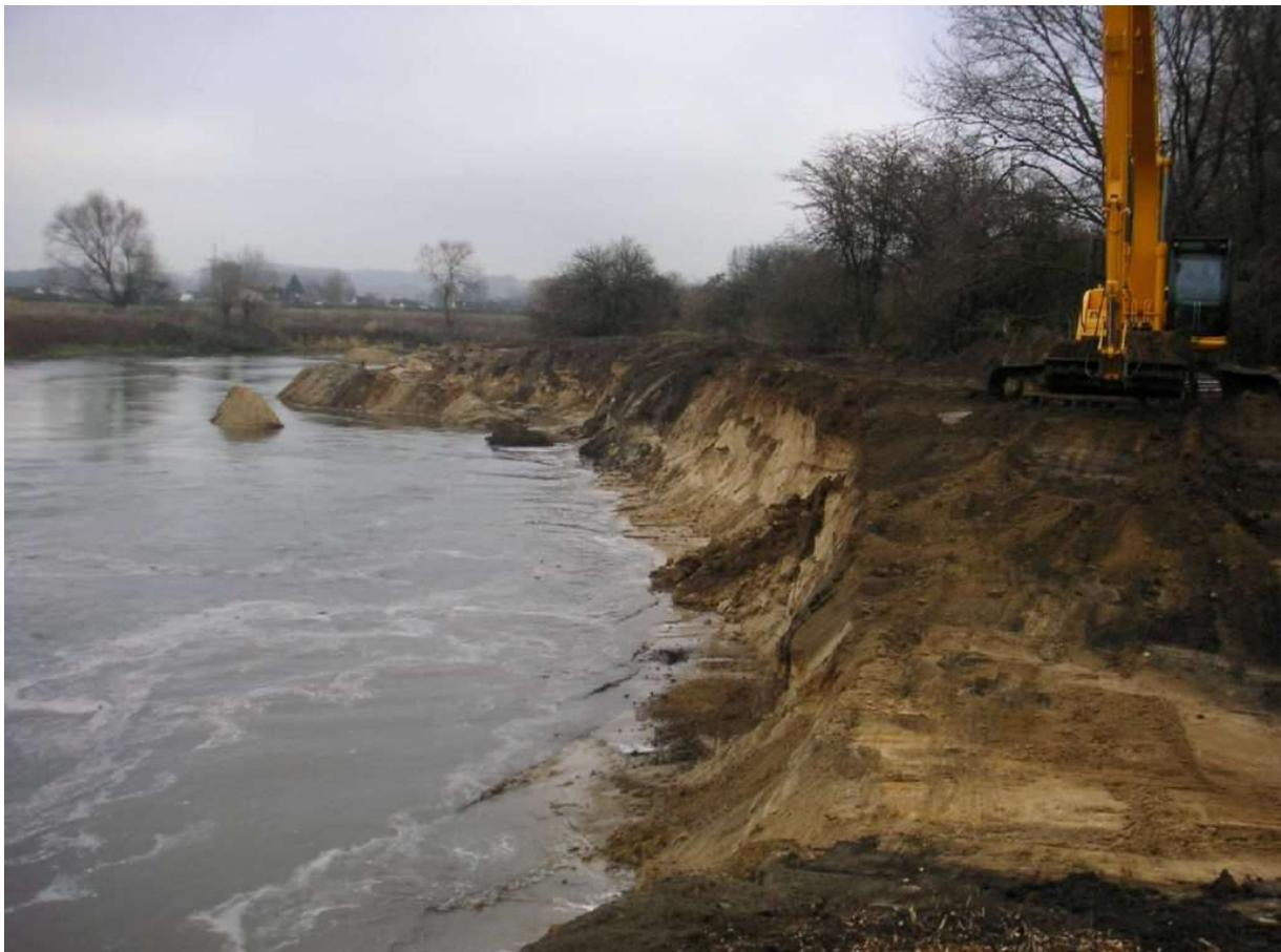
**Abb. 1:** Uferentfesselung linkes Lippeufer im Bereich des NSG „Lippeaue von Lünen bis Schleuse Horst“.
