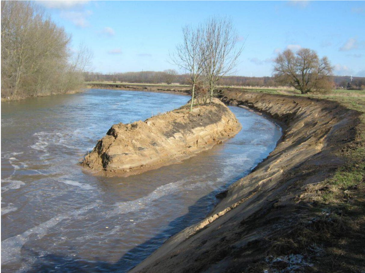
Abbildung 2: In 2010 umgestaltetes, rechtsseitiges Lippeufer im NSG „Lippeaue von Lünen bis Schleuse Horst“.
