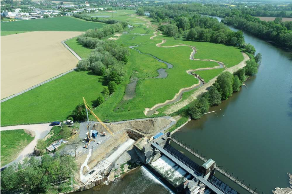
Baugrube des Fischpasses und der Restwasserschnecke (im Vordergrund unten links) sowie das naturnahe Umgehungsgerinne (Hintergrund rechts) 2022 Foto: Ingenieur-Büro Wolfgang Klein Wasserwirtschaft – Gewässerökologie
