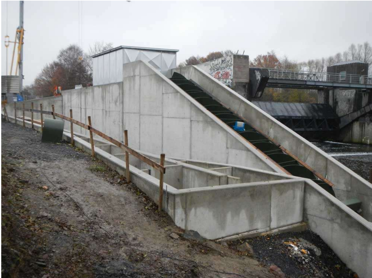
Der fast fertiggestellte technische Fischpass mit eingebauter Wasserkraftschnecke am 30.11.2022
