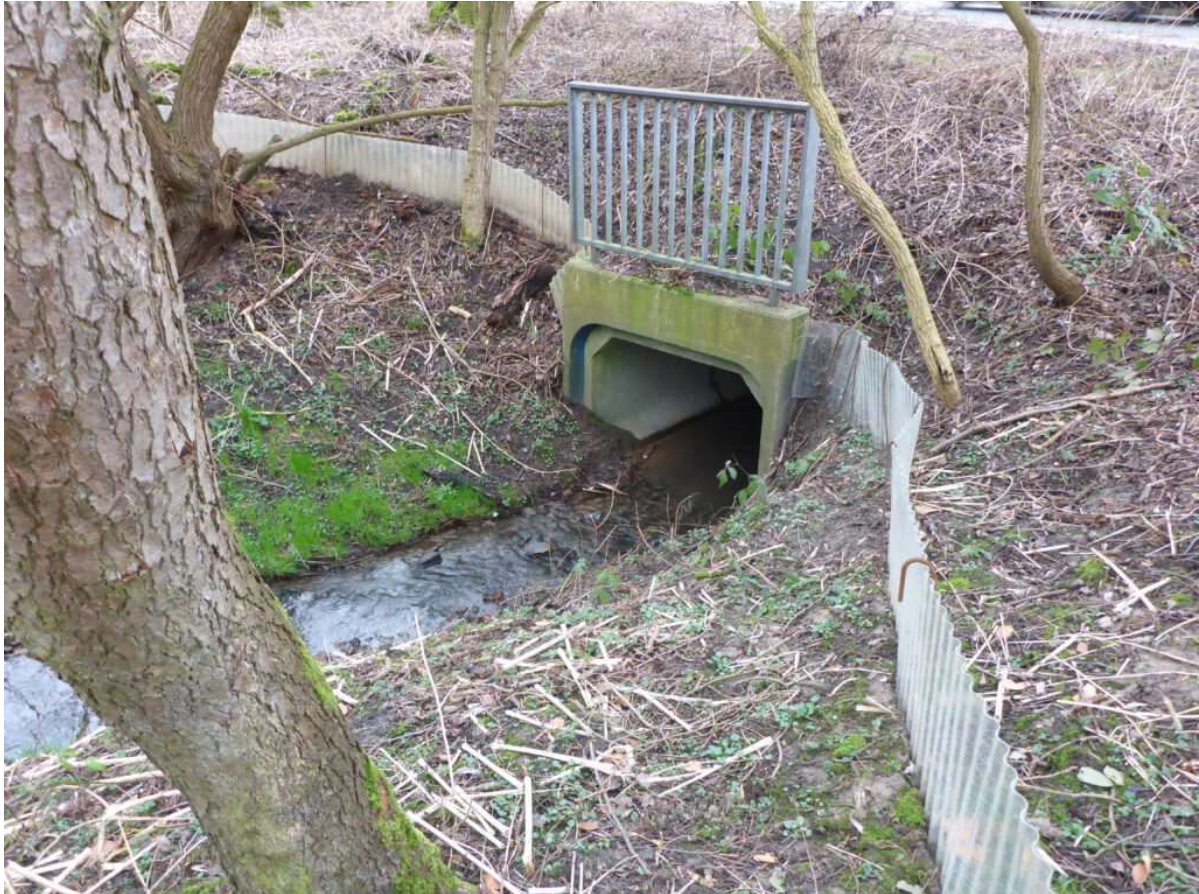
Abb. 5: Durchlass Süggelbach mit daran anschließendem mobilem Fangzaun.
