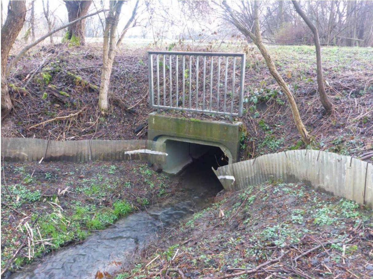
Abbildung 10: Amphibienschutzzaun an der Brechtener Straße, der hier beidseitig am Durchlass des Süggebaches endet. (Foto vom 15.03.2021).
