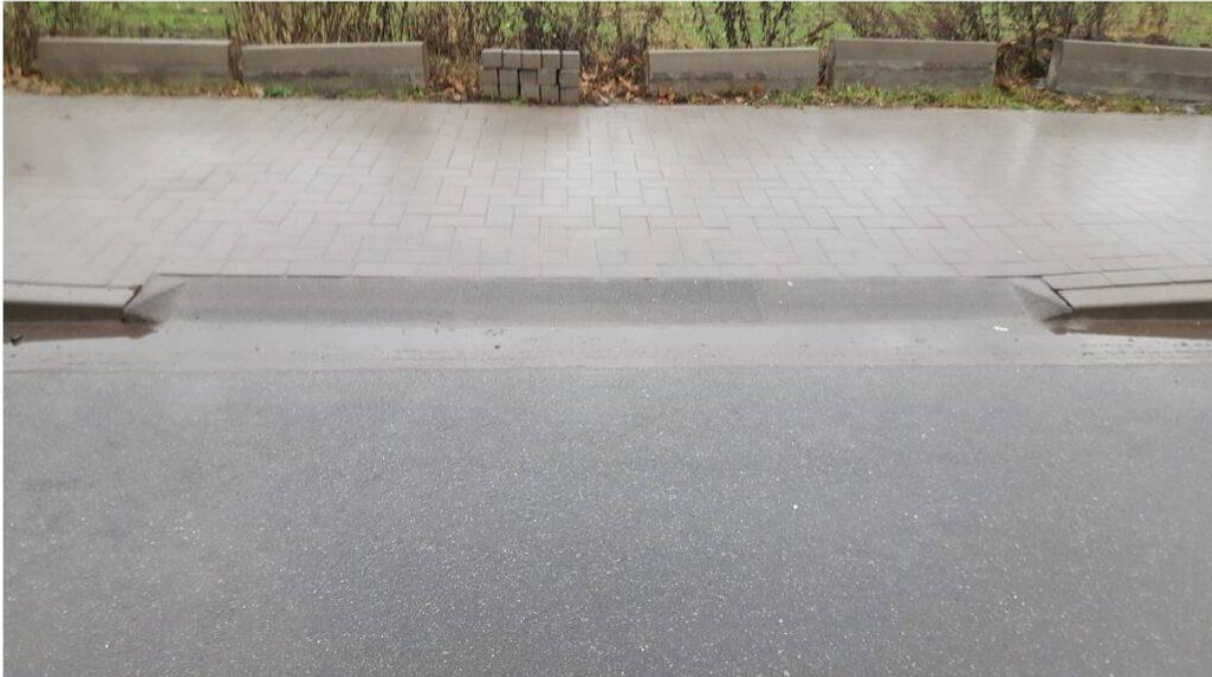
Abbildung 13: Austausch von konventionellen Bordsteinen gegen Schrägbordsteine.
