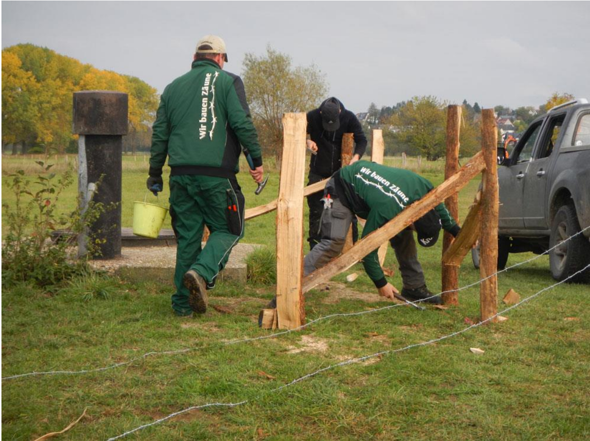
Zauninstandsetzung im Winter 2020/21
