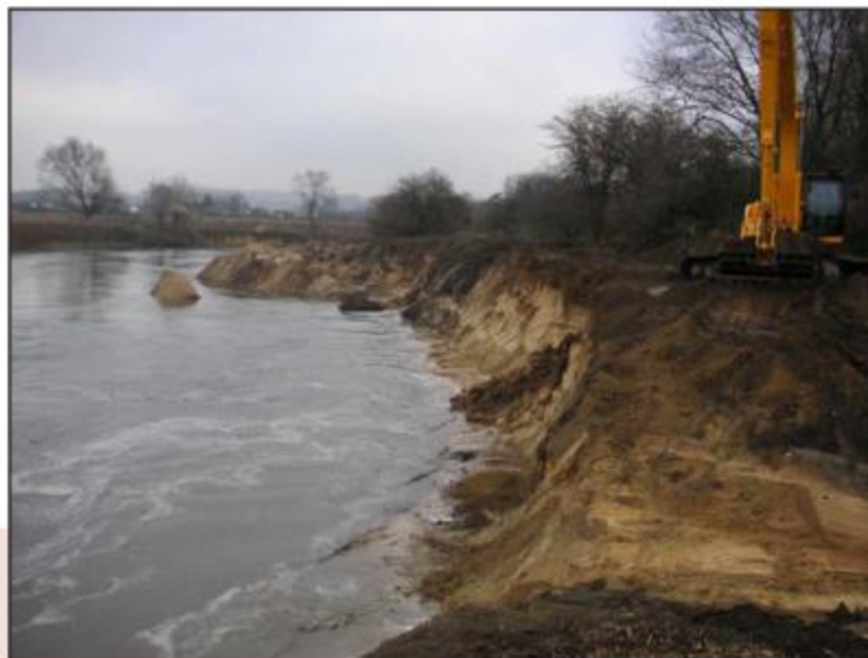
Abb. 77: Uferentfesselung des linken Lippeufers im nördlichen Bereich des ehemaligen NSG Zwiebfeld
