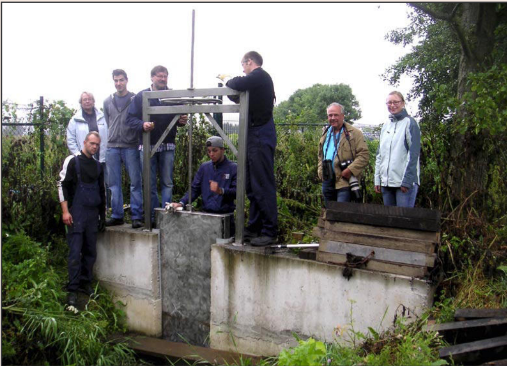
Abb. 100: Auf Antrieb passgenau - die Umweltwerkstatt Lünen beim Einbau des neuen Absperrschiebers
