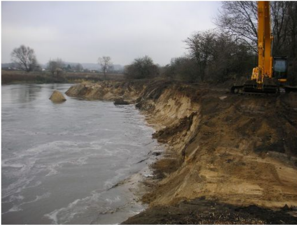
Abbildung 1: Uferentfesselung linkes Lippeufer im Bereich des NSG „Lippeaue von Lünen bis Schleuse Horst“.
